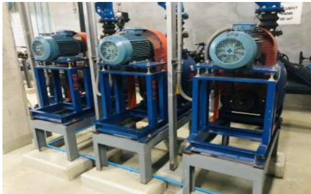
ตัวอย่างปั๊มสูบน้ำออกไปลำรางสาธารณะ แบบ DRY PITCH
